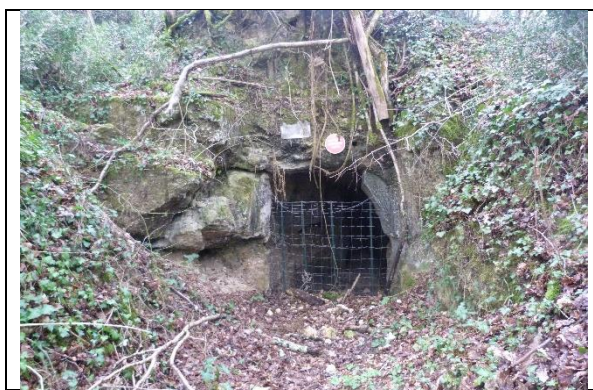
Figure 1 : Vue de l'entrée principale de la carrière prioritaire
